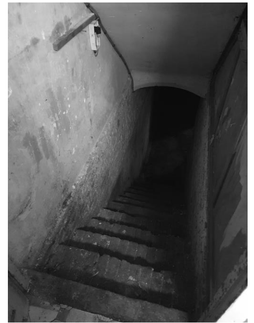
ESCALIER SOUS SOL
